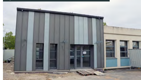
Les travaux d'extension de l'accueil périscolaire de la Tilleulière en avril.
