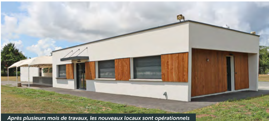
Après plusieurs mois de travaux, les nouveaux locaux sont opérationnels
